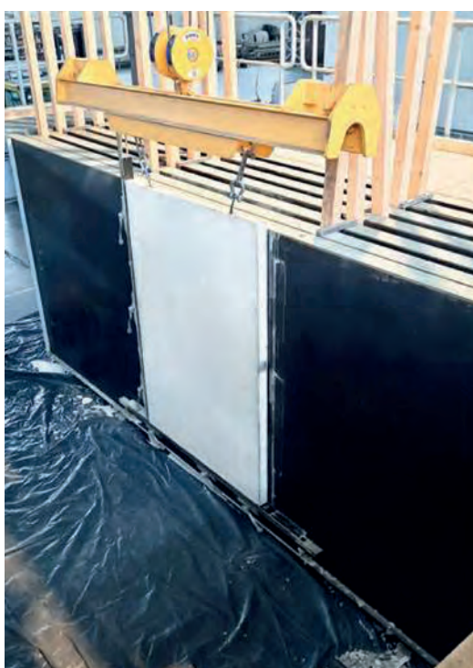
Ausschalen und Bauteilentnahme aus der Batterieschalung
